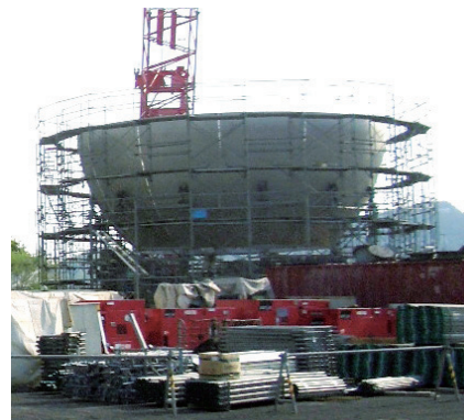
写真7 ステップⅢにおける仮支柱上の下部鏡板 Photo. 7 Lower head plate on temporary prop in step III
