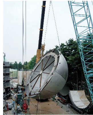
写真6 ステップⅠにおける下部鏡板反転 Photo. 6 Lower head plate reversing in step 1
