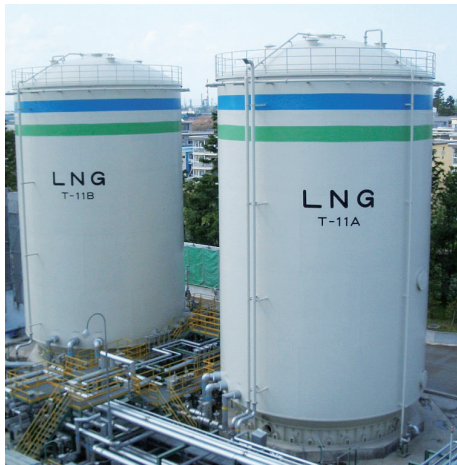
写真1 常圧断熱式縦置円筒形低温貯槽 (LNG 貯蔵用) Photo. 1 Double shell vertical refrigerated tank (for LNG)
