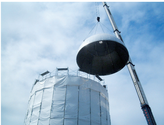
写真5 上部鏡板搭載 Photo. 5 Installing of the upper head plate
