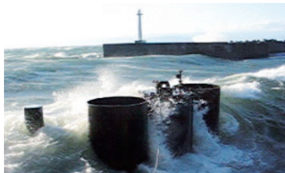
日時・場所：2006年8～11月・沼津港 施工数量：鋼管φ1422mm×3本
