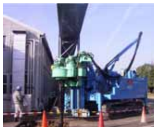
写真 10 上空制約施工
