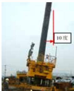
写真 7 斜杭施工 (大径)
