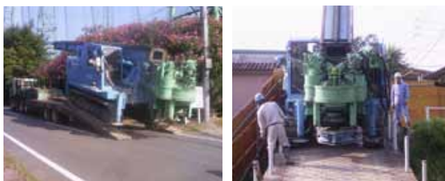
写真5 小型杭打ち機搬入
