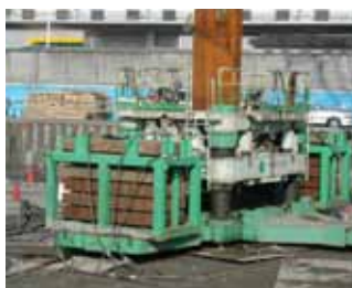
写真2 大径施工 Photo.2 Construction machine (large size)
