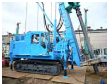
写真 8 斜杭施工 (小径)
