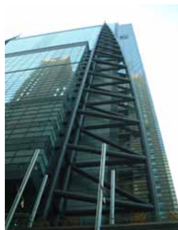
写真3 アンボンドブレース採用物件（日本テレビタワー） Photo.3 Unbounded braces applied constructional case (Nittele tower)
