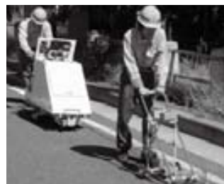
写真 3 テスラの調査状況 Photo.3 Operation scene of SUPER CODINS TESLA
