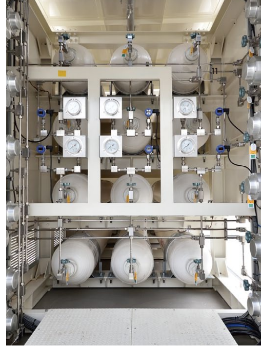
バンクローテーションで制御される蓄圧器ユニット。東京大井水素ステーションでは、中圧段、高圧段と2段階に分けて圧力を高め、出荷用トレーラーには中圧段で充填する。写真は高圧段の蓄圧器ユニットで、2本×3バンク×2系列からなる。
