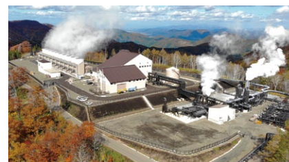
山葵沢地熱発電所
