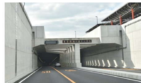
東京港海の森トンネル 沈埋面
