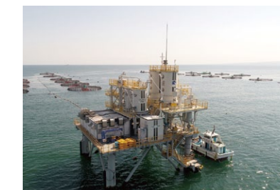
自動給餌設備システム(鳥取県境港市)
