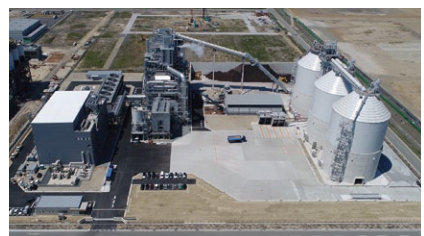
荻田バイオマス発電所
