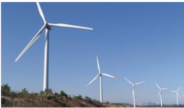
(株)エヌエスウインドパワー・ひびき
