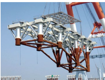
東京港中央防波堤外側地区岸壁築造工事
