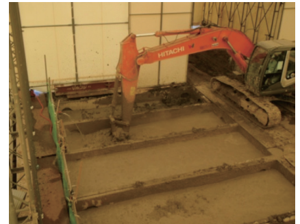
仮設テント内での攪拌混合
