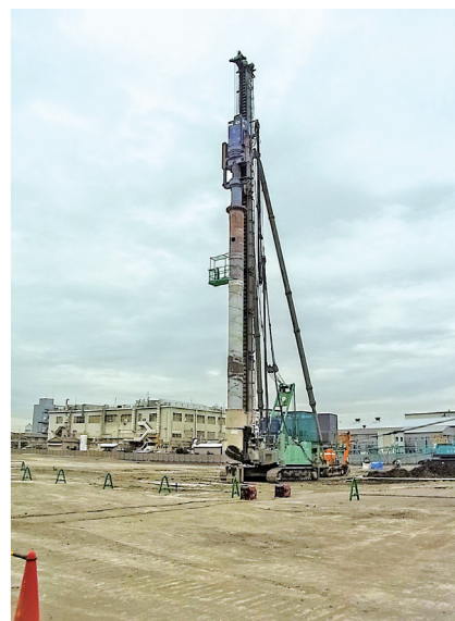
建設予定現場
