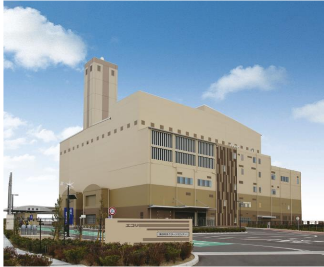
【外観写真(竣工後)】
