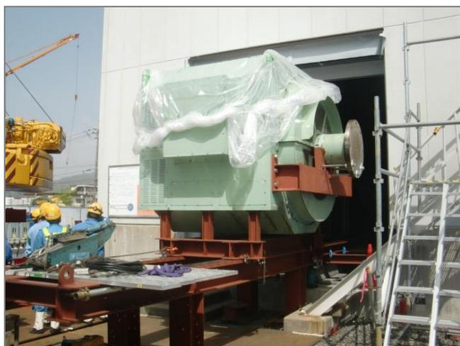
発電機搬出（建屋開口よりレール移動）
