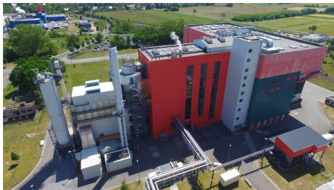
【既設プレムニッツ廃棄物発電施設】 © EEW Energy from Waste Premnitz GmbH
