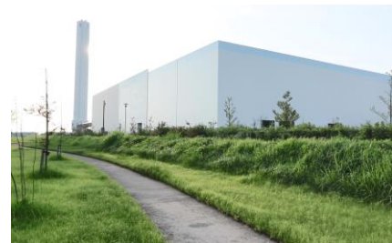
【施設外観(外壁側)】
