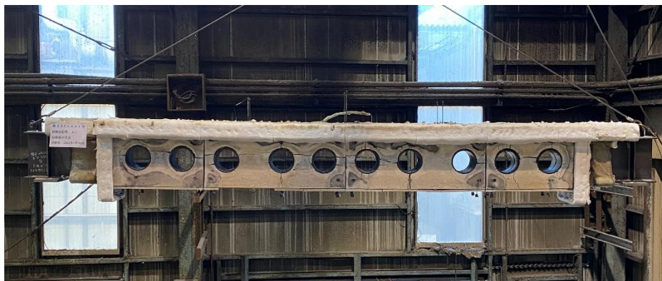
【耐火試験終了後の鉄骨梁】
