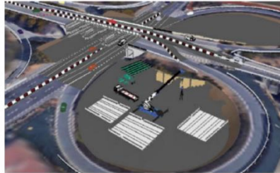
図3: 更新橋 (NVピッドブリッジ) の地組み
