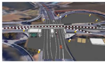
図2: 移動台車による既設RC橋の撤去 (対面通行)
