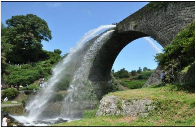
【熊本県通潤橋の全体写真】
