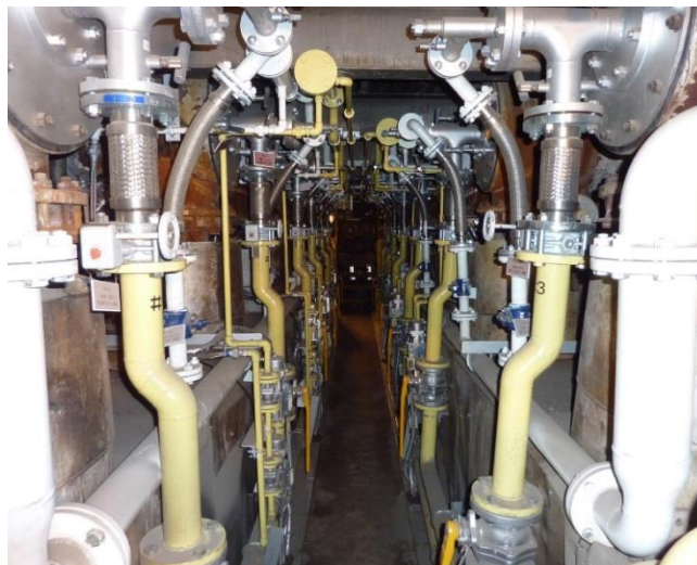
【改造後の燃料供給システム】
