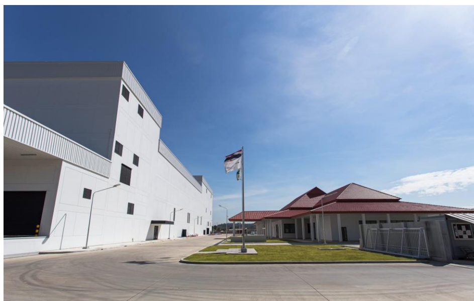
【Spiberが建設した構造タンパク質の量産プラント】
