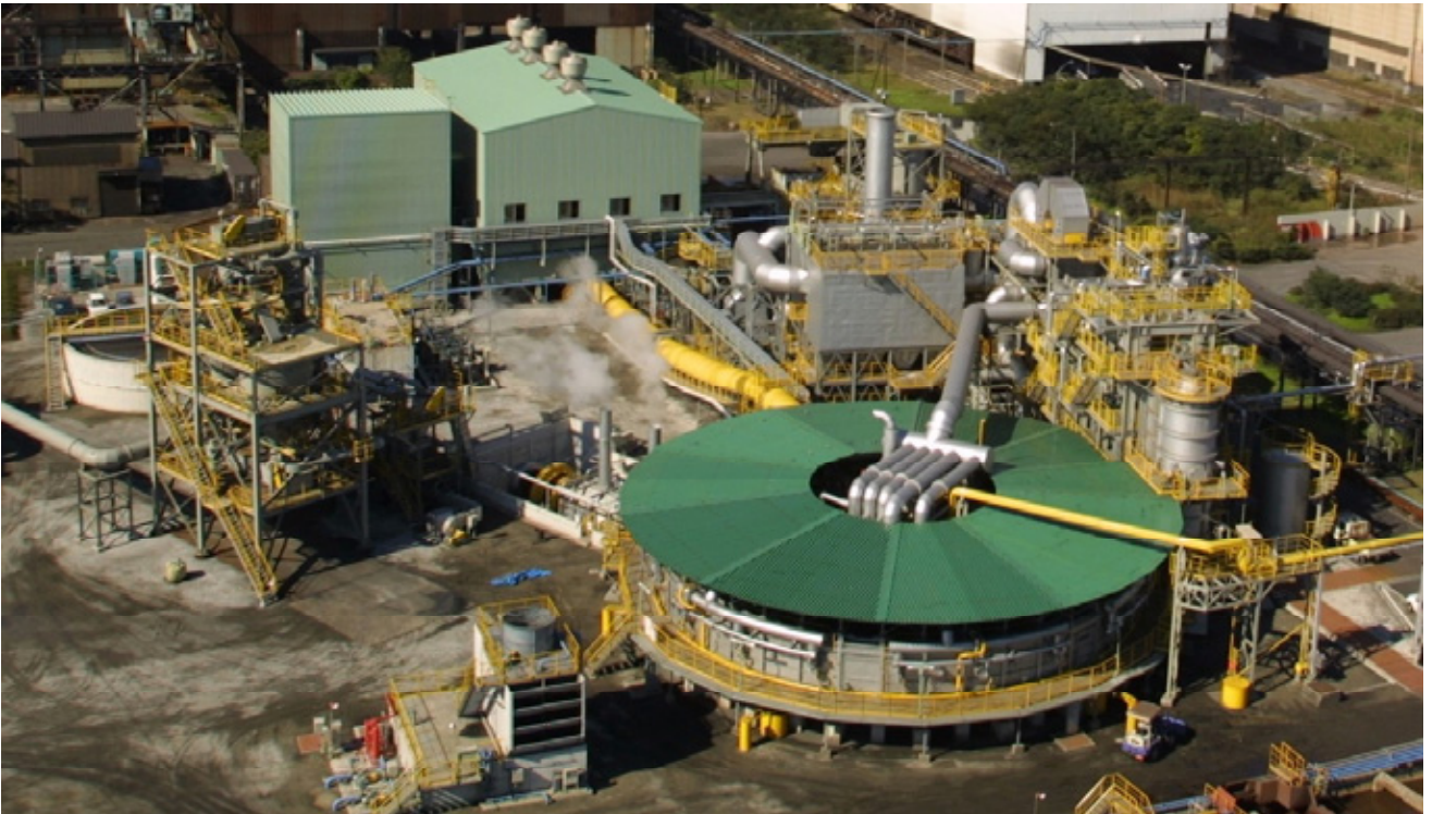
新日本製鐵(株)君津製鐵所 RHF 設備
