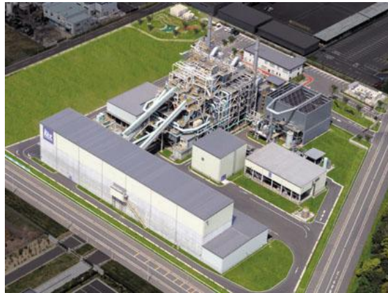
北九州エコエナジー(株)全景
