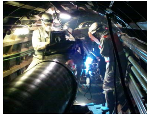
図5 シールド内溶接状況 (500A×12.7mmt X60)
