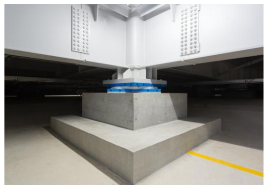
【「NS-SSB®」据付状況写真】
