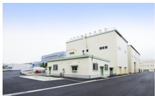
【日明汚泥燃料化センターの外観】
