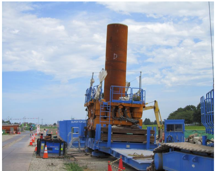
【斜杭施工の様子】
