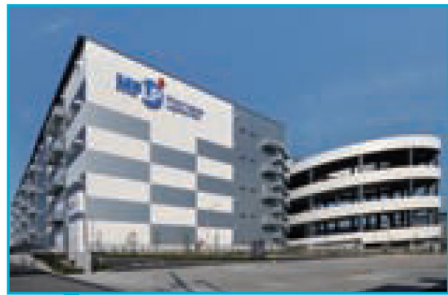
大型物流施設： 3階～6階建て
