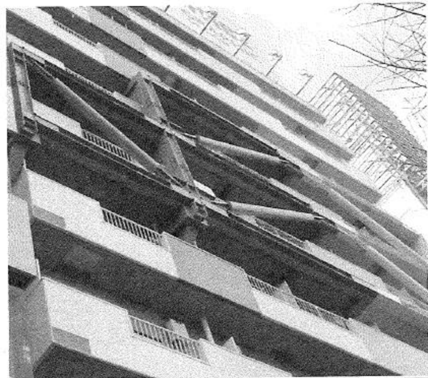
アンボンドブレース設置状況、外観(上)と内側(下)
