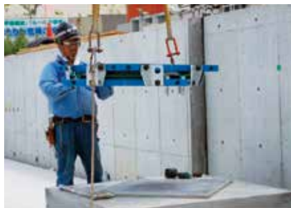
仮設治具を用いた免震装置据付け状況
