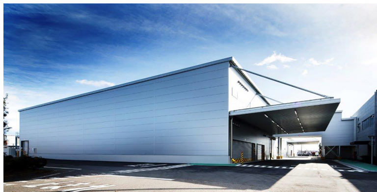
愛知製鋼「新パワーカードリードフレーム工場」
