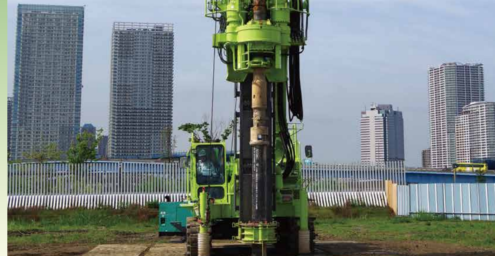
「HIステージアROUND東京」建設現場 東京都豊洲 / 2017年4月開業予定
