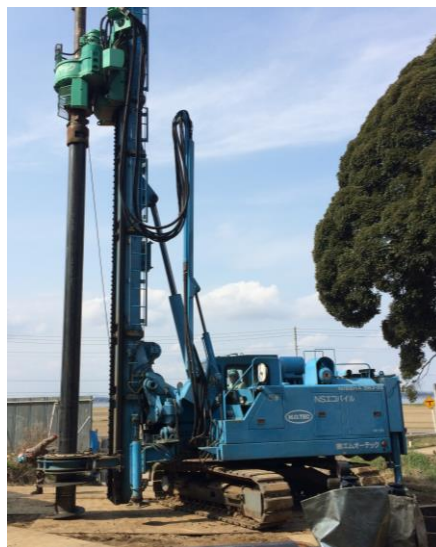
図5 NSエコパイルDUO ® の施工
