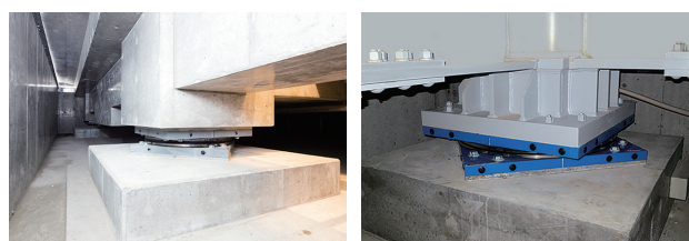
球面すべり支承「NS-SSB®」の部材構成
