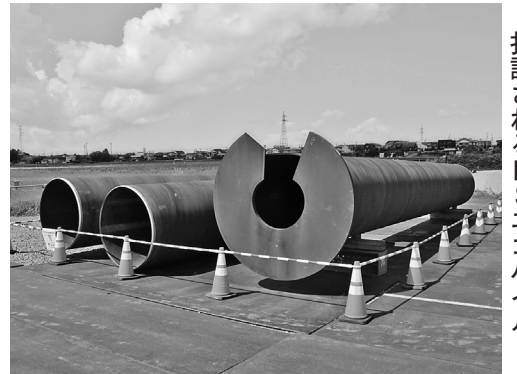
打設されるNSEコパイル
