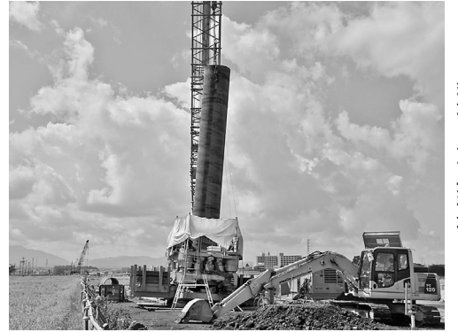
斜杭の施工現場
