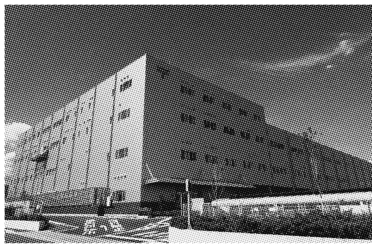
建物内の積載物の重量が変化しても免震に影響しない（NS-SSBを採用したビル）
