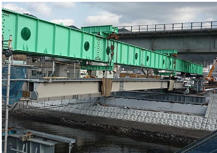
【施工状況写真】
