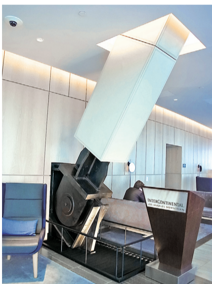
「ウィルシャーグランドタワー」内のホテルに設置された「アンボンドブレース」。意匠がそのまま生かされた
