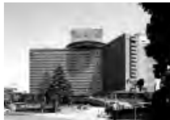
①既存建物、全景
