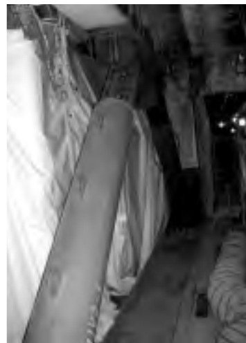
②補強制振ブレース
