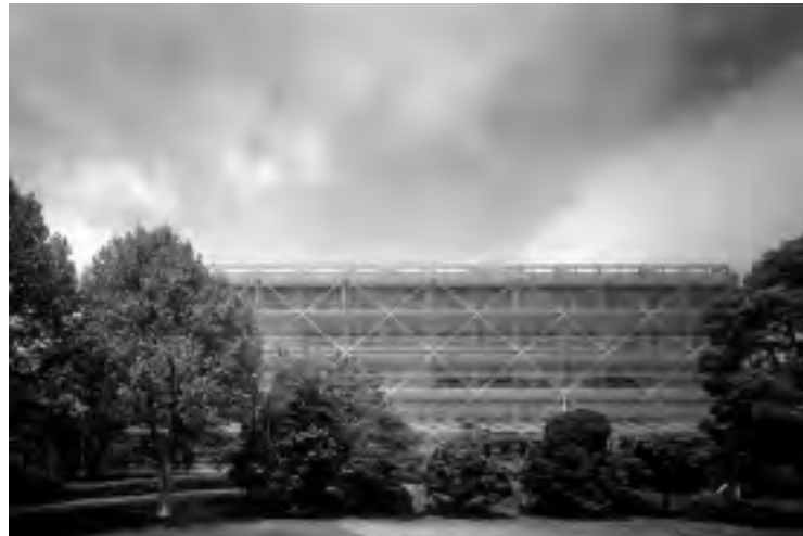
①補強後全景（撮影：石黒守）
