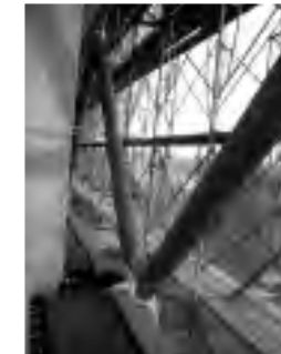
⑥制振ブレース取付
