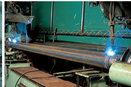
パイプとエンドコーンの溶接
