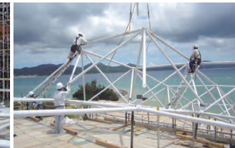
上弦材・斜材建方
