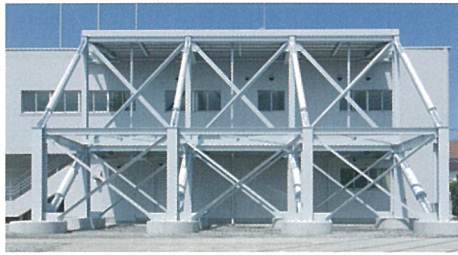
データセンター
